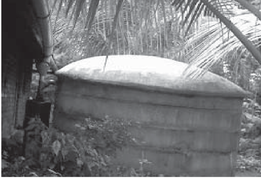
ಚಿತ್ರ 8. ಪೂರ್ಣಸಿದ್ದಗೊಂಡ ಸಿಮೆಂಟ್ ಬಳೆ ತೊಟ್ಟಿ. ಈ ಟ್ಯಾಂಕಿಗೆ ಛಾವಣಿಯಿಂದ ಶುದ್ಧಗೊಂಡ ನೀರು ಹರಿದು ಹೋಗಲು ಅವಕಾಶ ಕಲ್ಪಿಸಿರುವ ಕೊಳವೆಯನ್ನು ಗಮನಿಸಿ.
