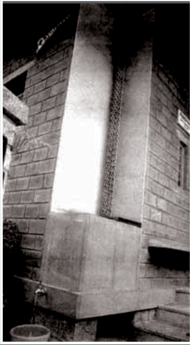
ಛಾವಣಿ ಮಳೆನೀರು ಲೋಹದ ಸರಪಳಿ ಮೂಲಕ ಇಳಿದು ಬರುವಂತೆ ಮಾಡಿ ನೀರು ಸದ್ಯಕ್ಕೆ ಮಾಡಿಕೊಳ್ಳುವುದಲ್ಲದೆ ನೀರಿನ ಜುಳು ಜುಳು ನಾದವನ್ನು ಆಸ್ವಾದಿಸುವ ಪರಿ
